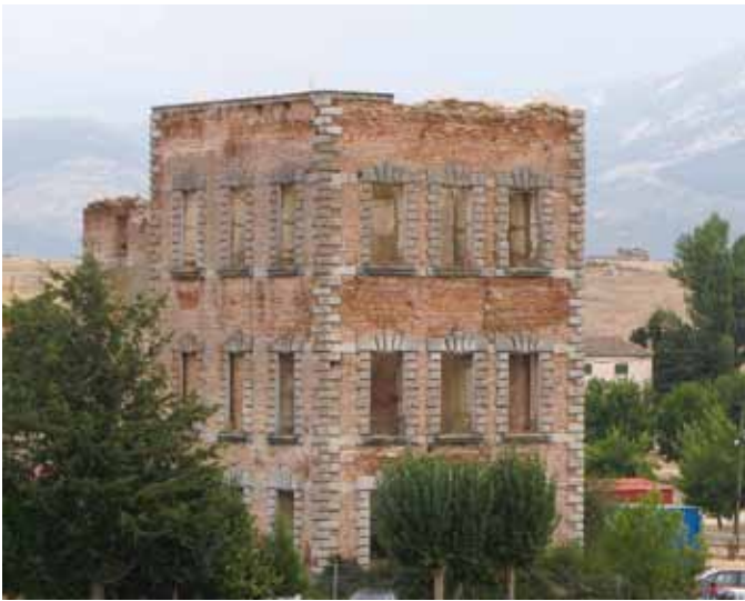
Fig. 4. Estado actual de la Torre Nueva (sur-oeste). Fotografía del autor.
